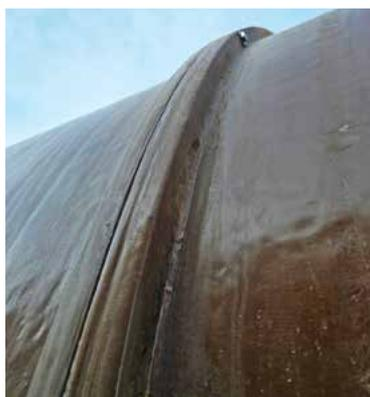
Präzise gefertigte Siloringe. Die Übergänge werden vor Ort dicht versiegelt.
