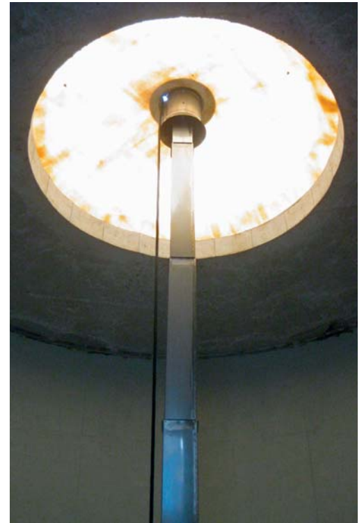
Edelstahl-Teleskop eckig – muss beim Befüllen nicht umgedreht werden.
