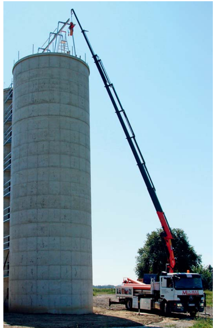
Die Krananlage und die Förderleitungen werden mit dem firmeneigenen Kranwagen montiert.
